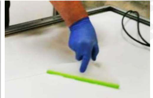
4. Versiegelung und Schutz der Backsheets mit REMISOL PV REPAIR TOP (2K-Beschichtung)
