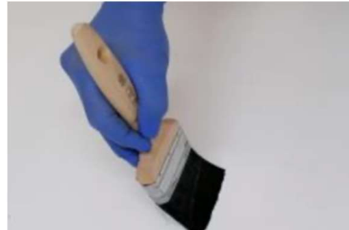
3. Füllen der Risse mit REMISOL PV REPAIR PRIMER (2K-Beschichtung)
